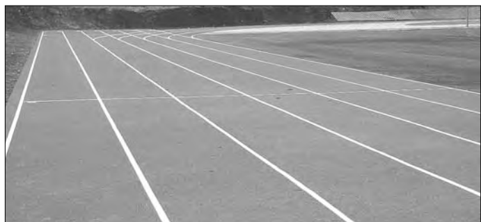
Budowa obiektu lekkoatletycznego wraz z modernizacją boiska
