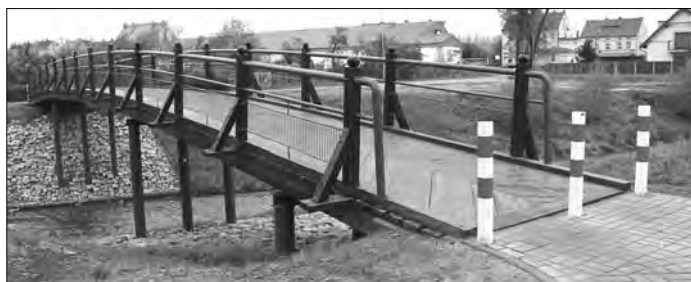
Przebudowa ul. Brzozowej i ul. Raclawickiej, ciągów pieszo-jezdných w ramach połączenia układu komunikacyjnego z wybudowaną kładką nad rzeką Skorą
