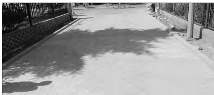
Budowa nawierzchni ulicy Krótkiej
