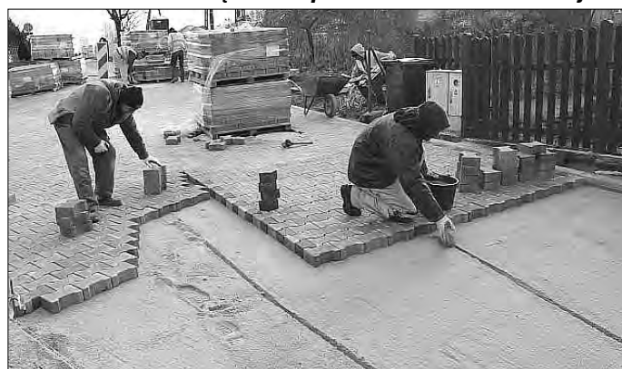
Przebudowa nawierzchni ulicy Południowej w Chojnowie
