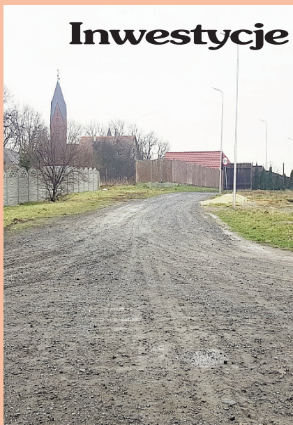
Budowa ul. Bielawskiej - ul. Legnicka i ul. Andersa
