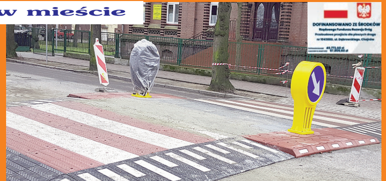
Przeście dla pieszych - ul. Dąbrowskiego
